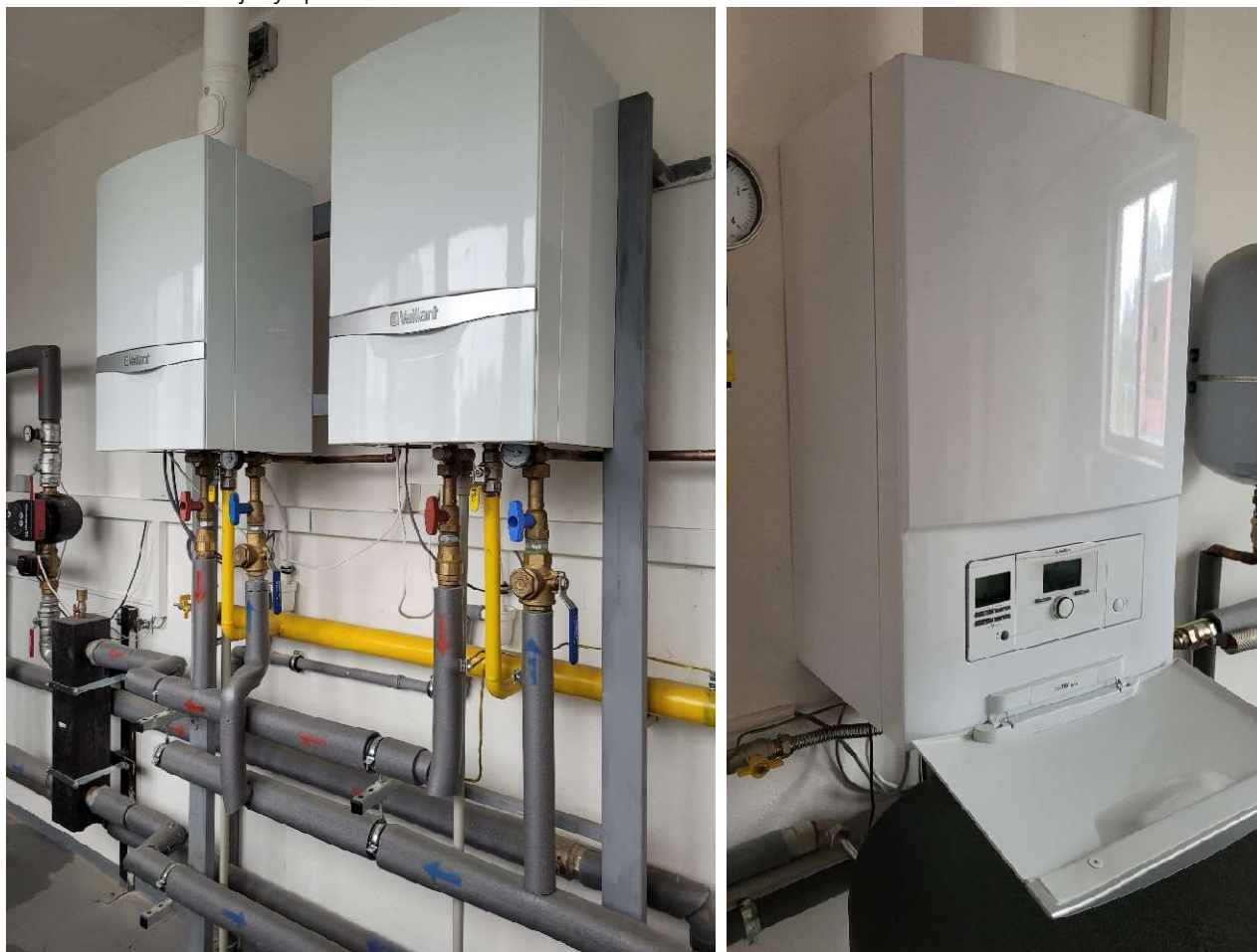
Obrázek č. 4.5.1.1: Zdroje vytápění a ohřevu TV
